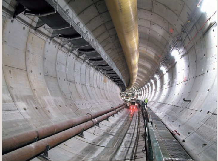
→ Le tunnel de l'A86.
