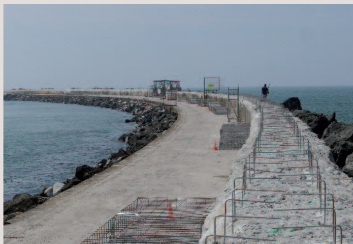
→ Réparation d'un ouvrage maritime en acier inox.
