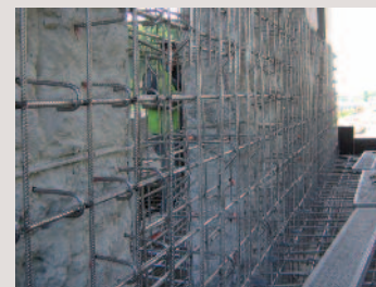
→ Réparation d'ouvrage d'art.
