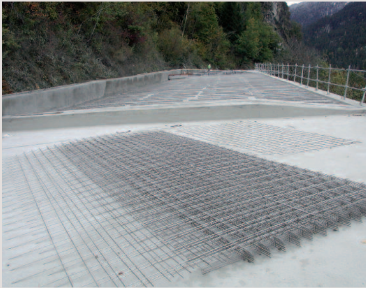
→ Treillis soudés pour la réalisation d'un pare-avalanche.
