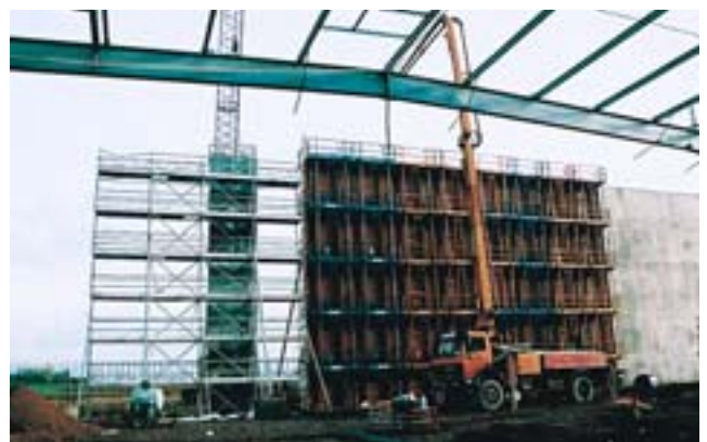
Photos : Hôicim Bétons
