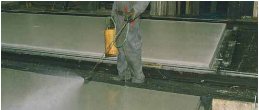
Cure d'une dalle préfabriquée
