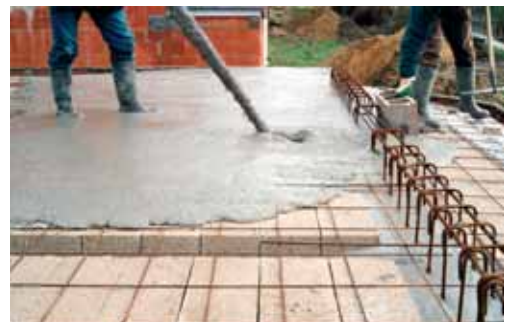
Mise en œuvre d'un béton autoplaçant (BAP)
