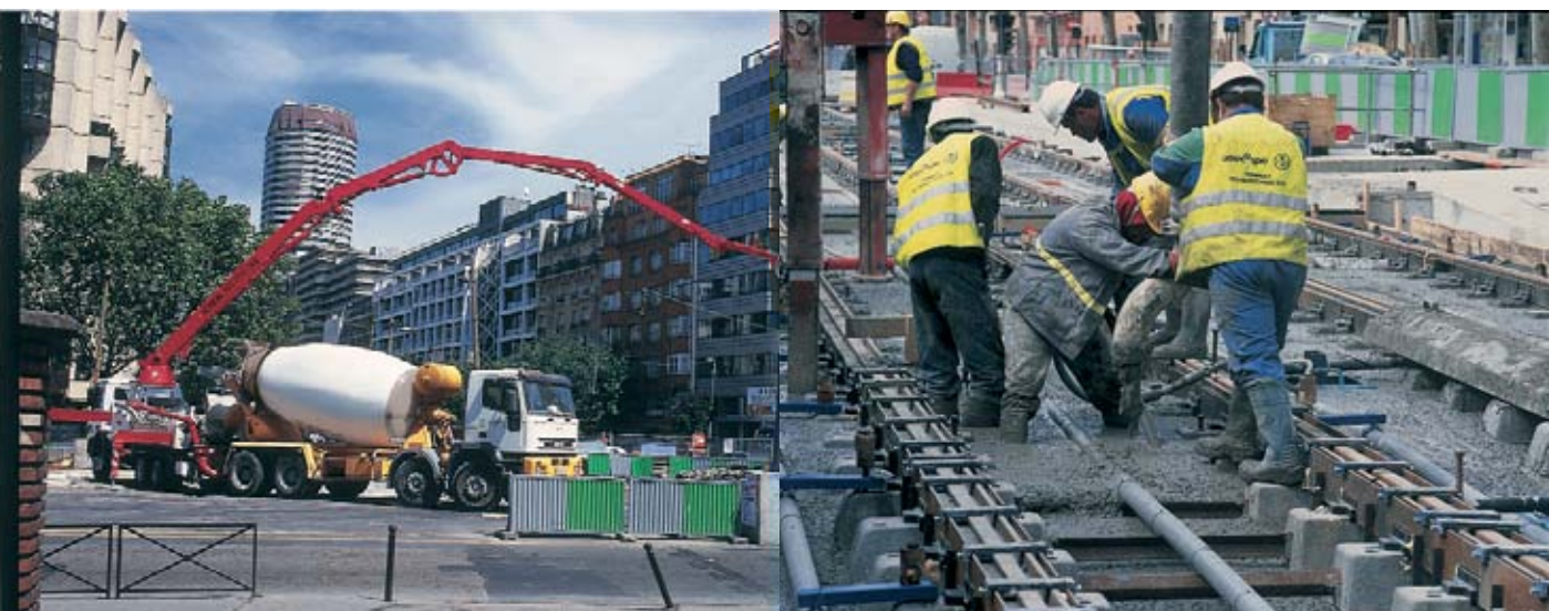
Réalisation des voies de circulation du tramway de Paris ▲ ▲
