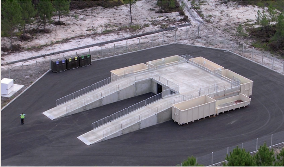
→ La nécessité de collecter et de gérer les déchets a fait naître le concept de solutions modulables telles que cette déchetterie Modulo béton®.
