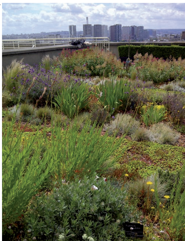
→ Végétalisation de dalles et terrasses existantes en béton.
