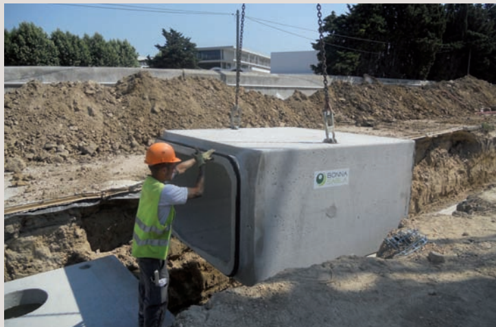
→ Pose d'éléments préfabriqués en béton.
