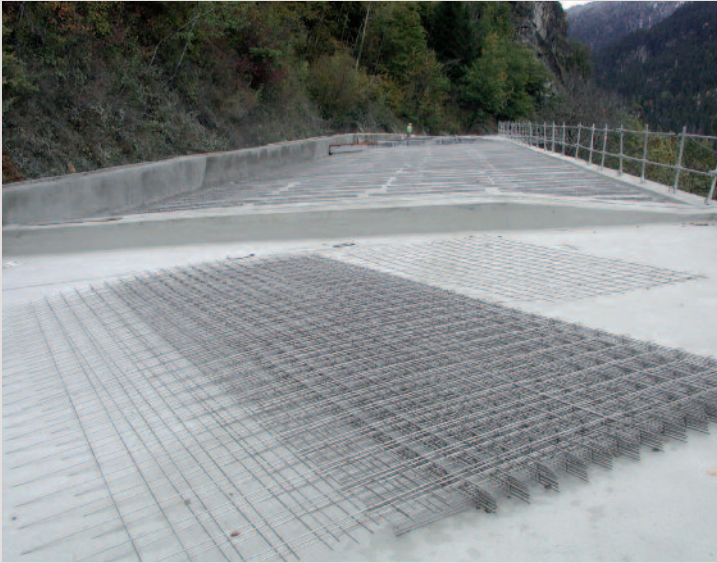
→ Treillis soudés pour la réalisation d'un pare-avalanche.
