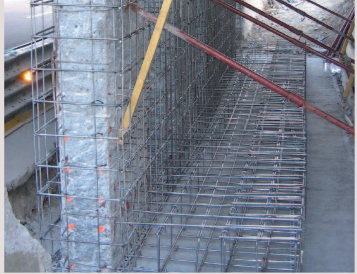
→ Réparations des piles de ponts endommagées par la corrosion (sel de déverglaçage).
