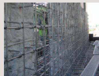
→ Réparation d'ouvrage d'art.
