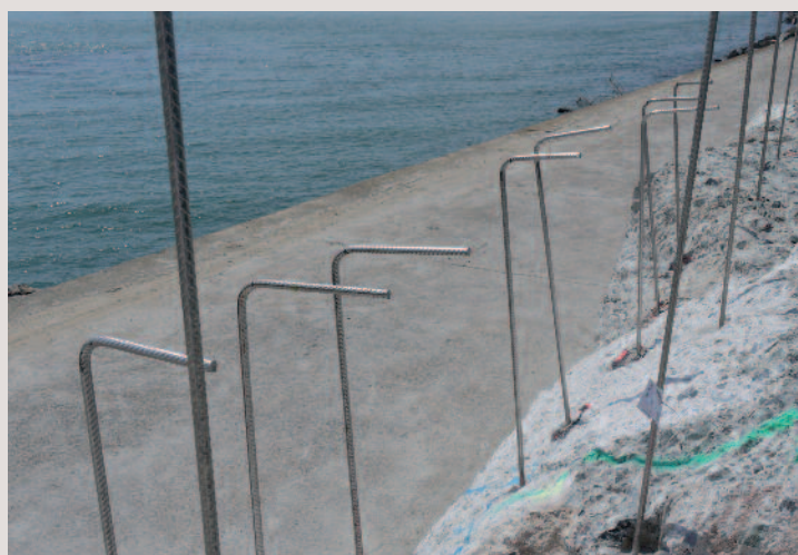
→ Liaisons d'ancrage des cadres.
