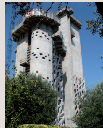
→ Construction de la résidence Le Simona à Monaco (98). Architecte : Jean-Pierre Lott.
