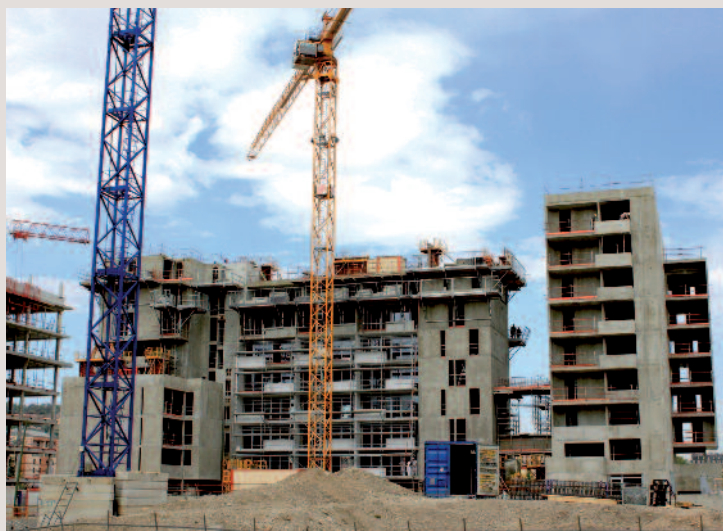
→ Construction de 66 logements sociaux, Lyon Confluence (69). Architecte : Emmanuelle Colboc et associés.
