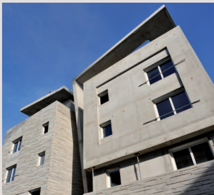
→ Le Gouz construction de 135 logements sociaux collectifs, Angers (49). Architecte : Studio Bellecour.
