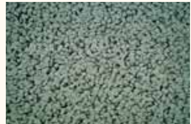
Aspect de surface d'un béton drainant.
