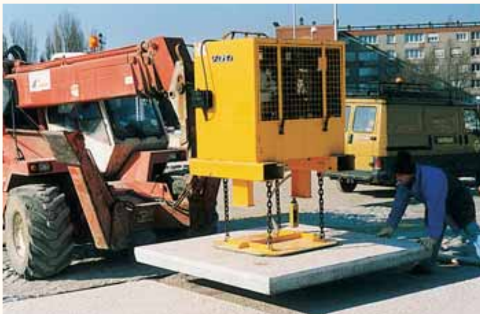
Pose par ventouses.
