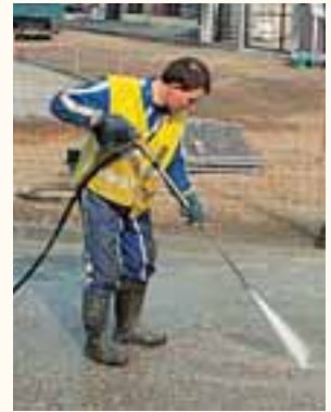
Béton désactivé : lavage au jet d'eau.
