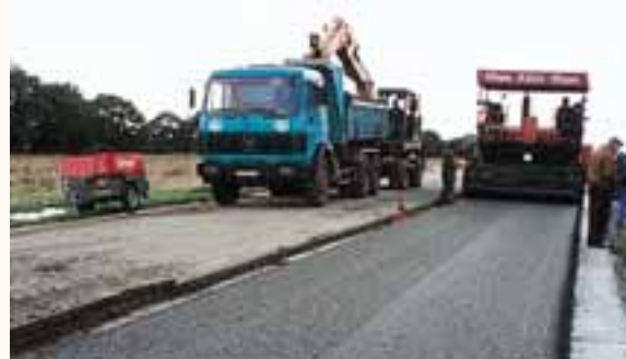
Mise en œuvre du béton drainant au finisseur.
