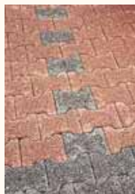
Chaussées réservoir avec revêtement en pavés.
