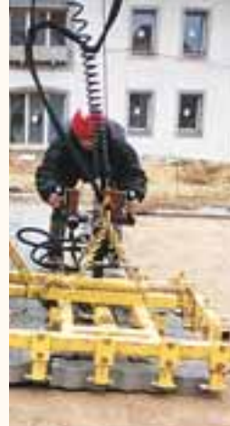
Pose des pavés à la machine.
