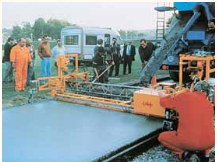
Mise en œuvre au vibro-finis seur.
