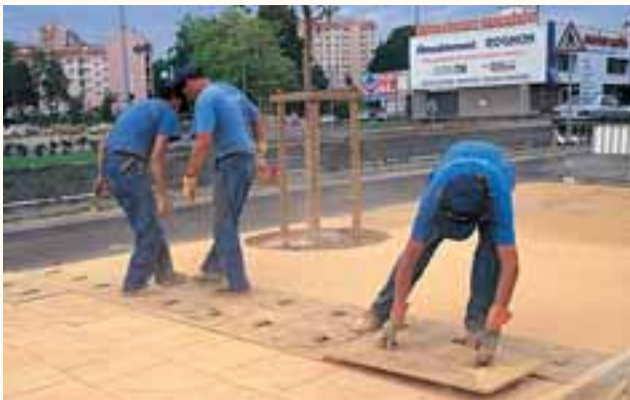
Béton imprimé : application des matrices.
