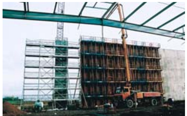
Photos : Hôicim Bétons
