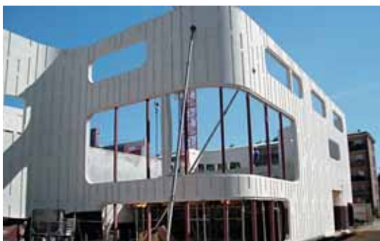
Chantier, mise en œuvre de coffrages complexes.
