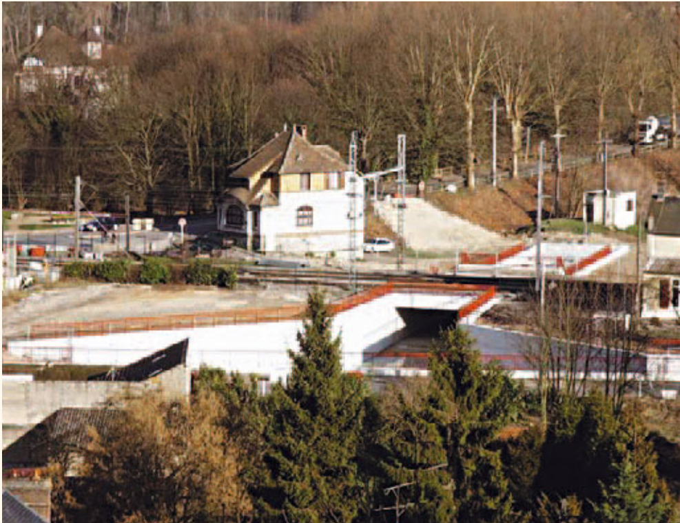
PONT SNCF "PN 30" À SAINT-PIERRE-DU-VAUVRAY (EURE)
