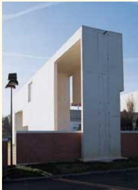
tique en béton blanc coulé en place reprend les lignes des ouvrages réalisés par Jean Deroche au niveau du portail du cimetière. Ce monument enjambe un mur composé d'éléments préfabriqués en béton de 2 m de hauteur revêtus de briques, qui constitue la nouvelle limite entre le cimetière et la voie. Un stationnement pour les visiteurs et une zone protégée pour l'accès des convois et des piétons sont aménagés à l'arrière.
